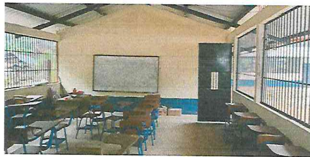
Foto 4: Pintura interior en el modulo No. 2
