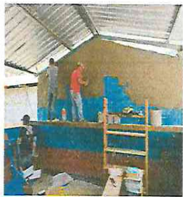
Foto1: Se puede apreciar la reconstruccion en curso del repello del modulo No. 1
