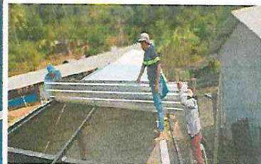
Foto 2: Mantenimiento de ventanas y cambio de estructura metalica en el modulo No. 1
